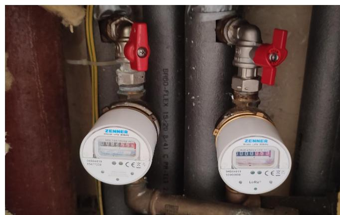
und wieder aufzudrehen. Zusätzlich empfehlen wir in regelmäßigen Abständen zu kontrollieren, ob ein Wasseraustritt an den Absperrventilen zu sehen ist.
